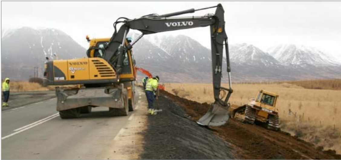
Mynd 8. Hringvegur á Moldhaugahálsi norðan Akureyrar, vegflái gerður flatari (Vegagerðin, 2012).
